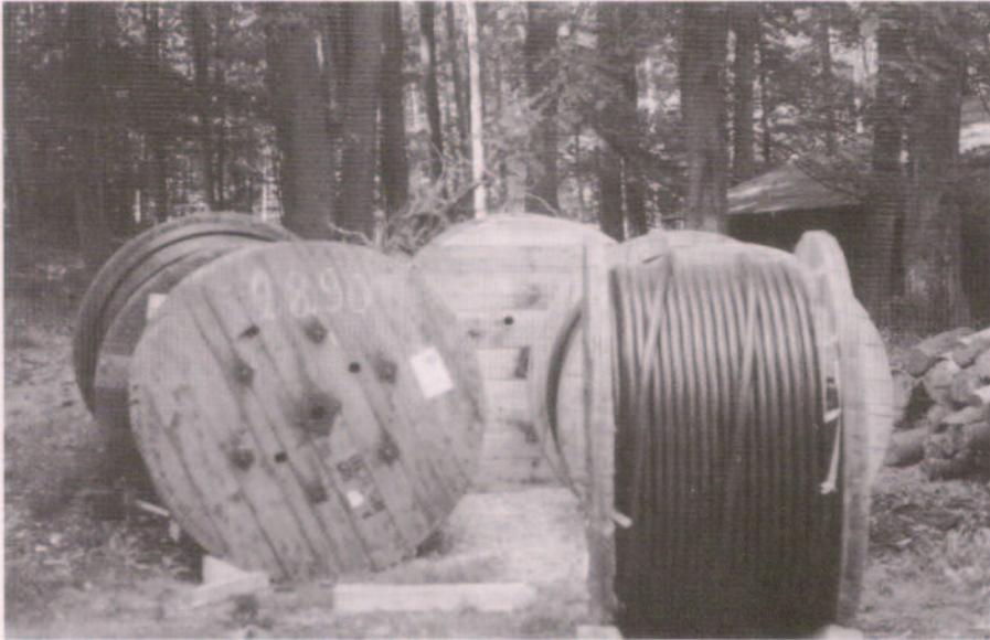
*Für die Stromversorgung der Lambertskreuz-Hütte wurden zwei 1500 m lange moderne Energieversorgungskabel mit einem Querschnitt  $4 \times 150 \text{ mm}^2$  verlegt. Damit wurde eine elektrische Energieversorgung rund um die Uhr erreicht.*
