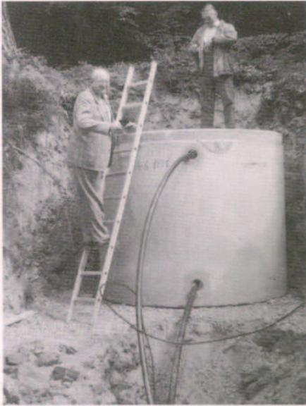
*Von den Quellen des Nadenbrunnens aus wird das Wasser zunächst zu einem Hochbehälter gepumpt. Von dort aus gelangt es in frostsicherer Tiefe zur Hütte.*
